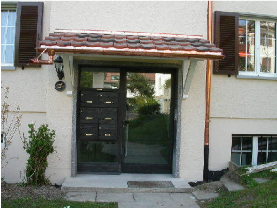
Vordach. Waldstr. 14, 8046 Zürich (1958)
